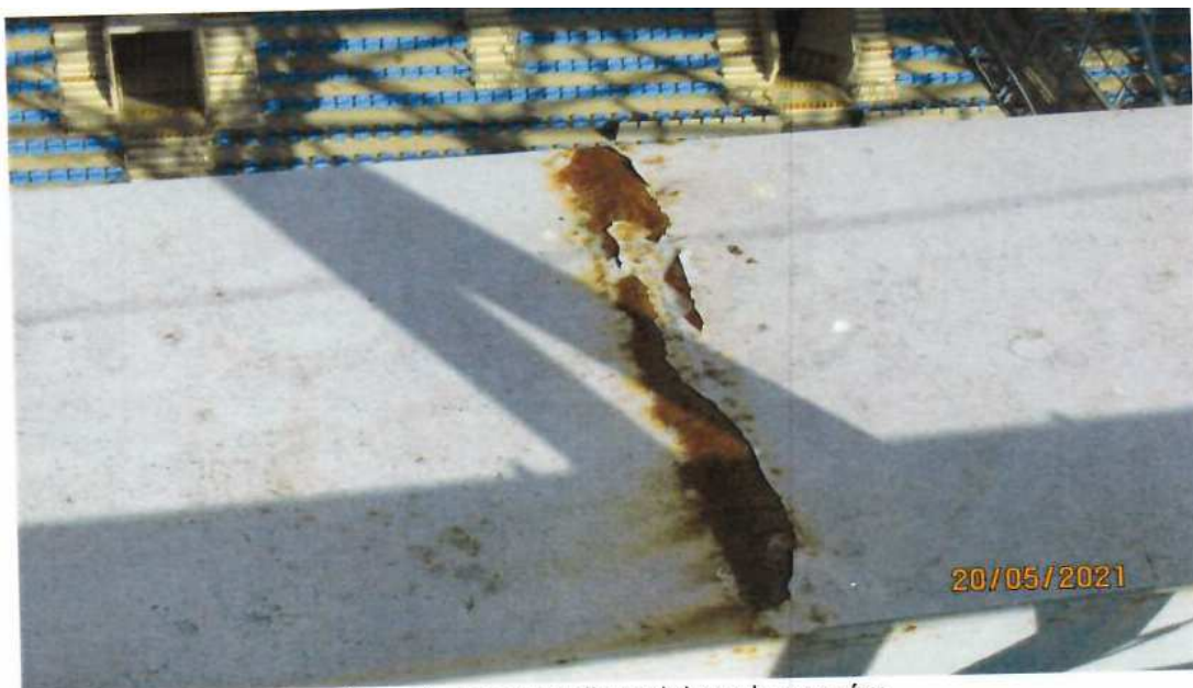
Korozja konstrukcji w miejscach spawów
