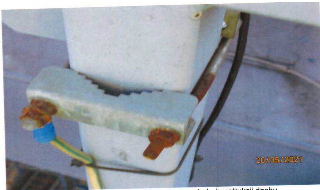
Korozja łączników urządzeń mocowanych do konstrukcji dachu
