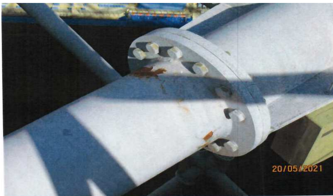
Miejscowa korozja konstrukcji stalowej
