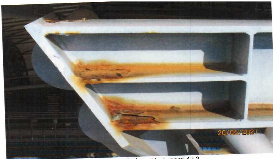
Korozja w węzłach nad trybunami 1 i 3
