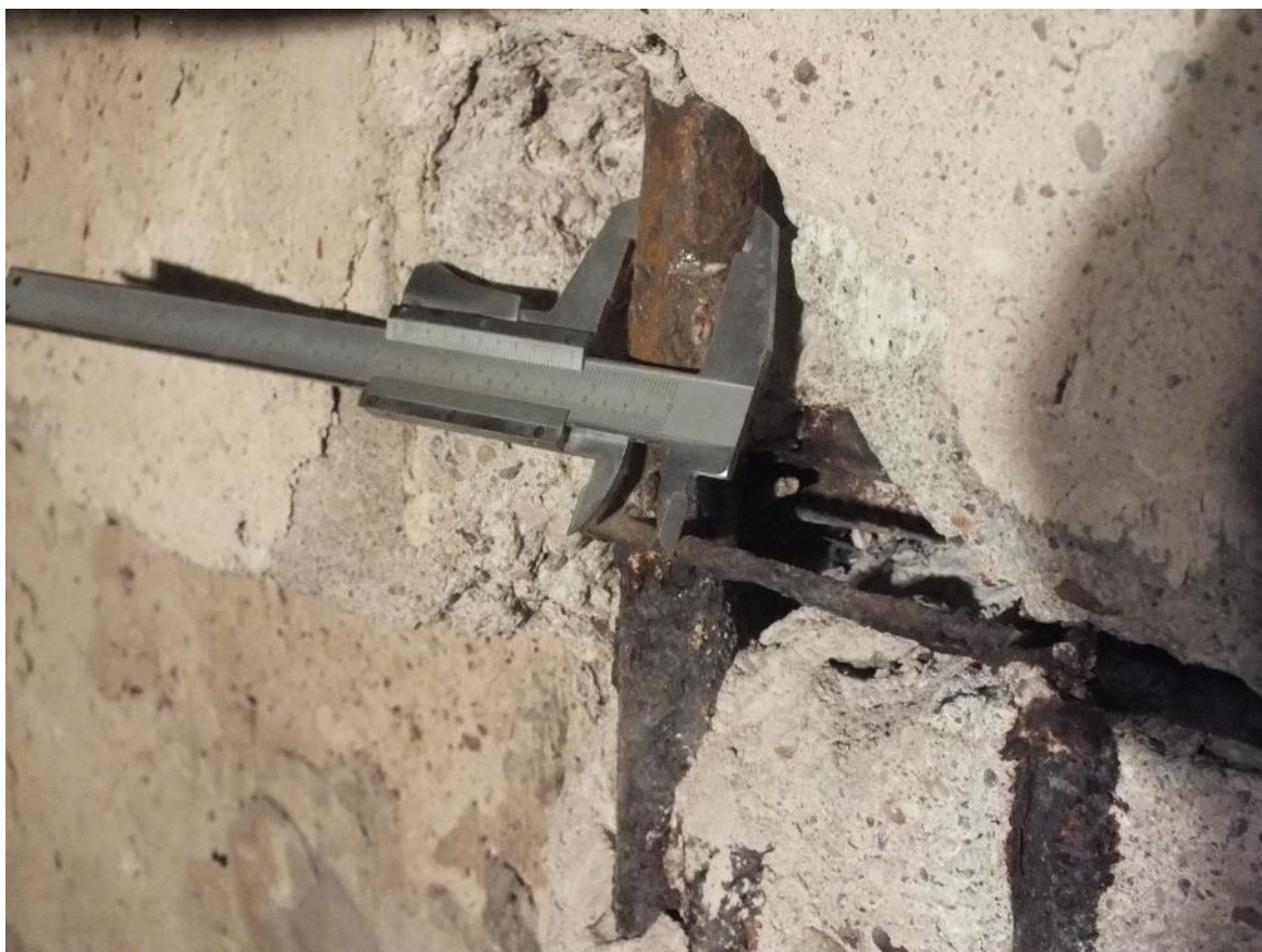
Fot.7. Widok odkrytego zbrojenia słupa
