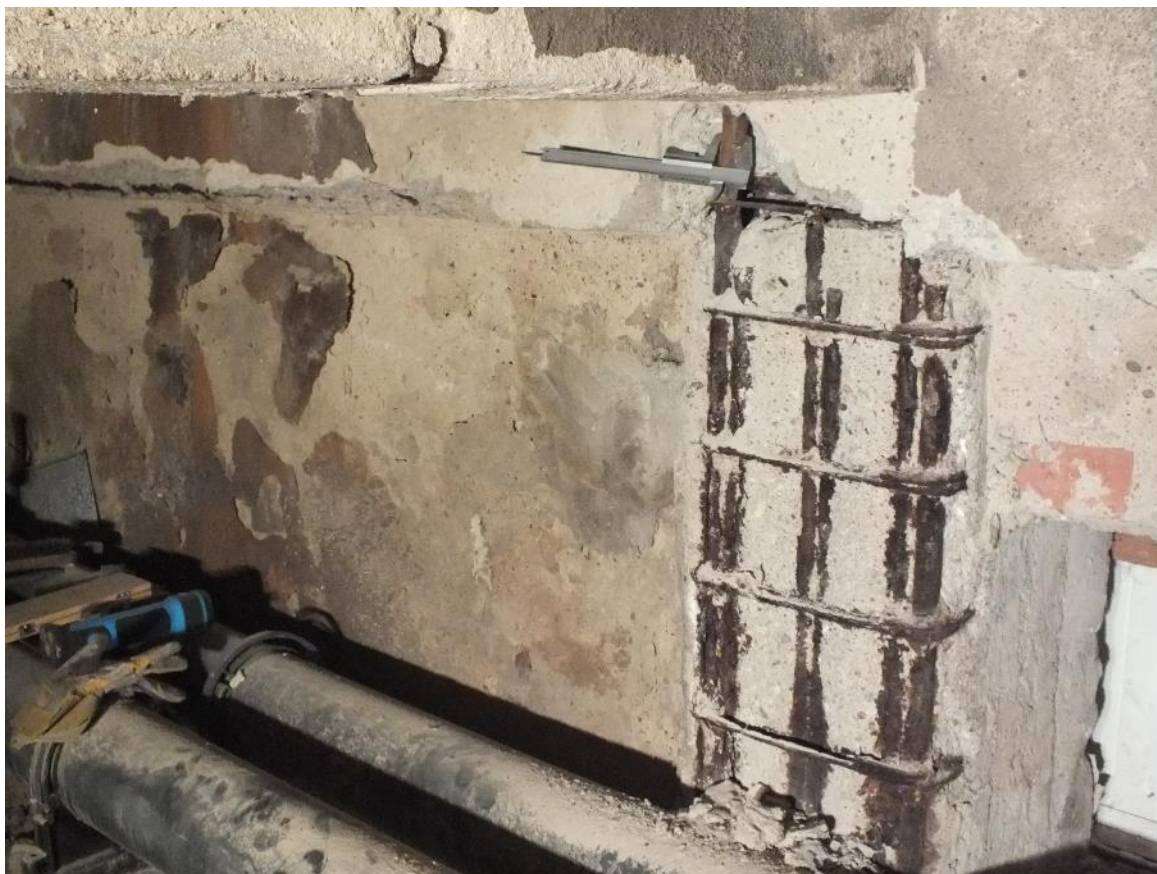
Fot.4. Widok odkrytego zbrojenia słupa
