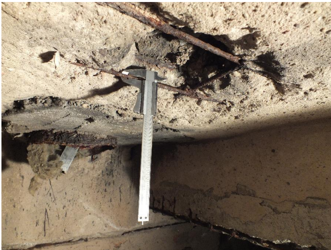
Fot.6. Widok odkrytego zbrojenia płyty stropu
