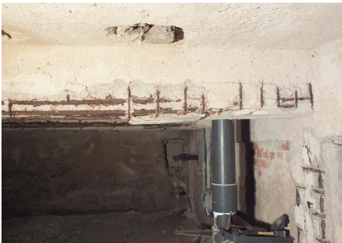
Fot.3. Widok odkrytego zbrojenia żebra i słupa
